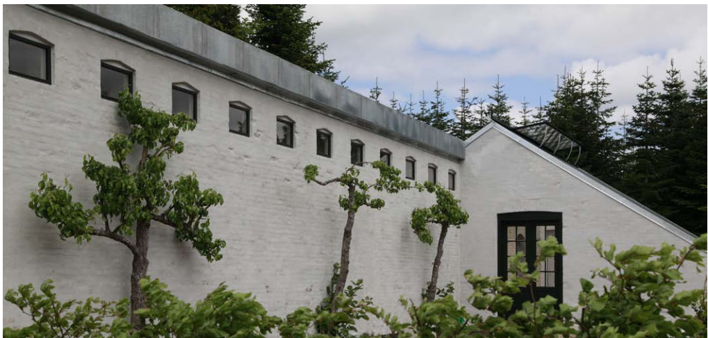
Nyrestaureret hus til elevernes undervisning og ophold i regnvejr
