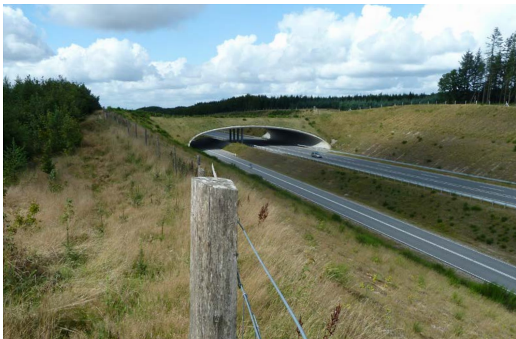
Faunabro mellem Bredsten og Vandel. Faunabroen tilgodeser arter som er knyttet til skov og muliggør at de kan bevæge sig rundt mellem skovene hhv. nord og syd for vejen uden at være i fare for at blive påkørt af trafik. Foto: Marianne Ujvári.
